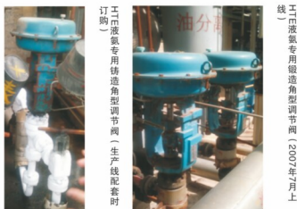
云南解化年25万吨硝酸铵造粒乙醚二塔装置合成自动放氨阀
