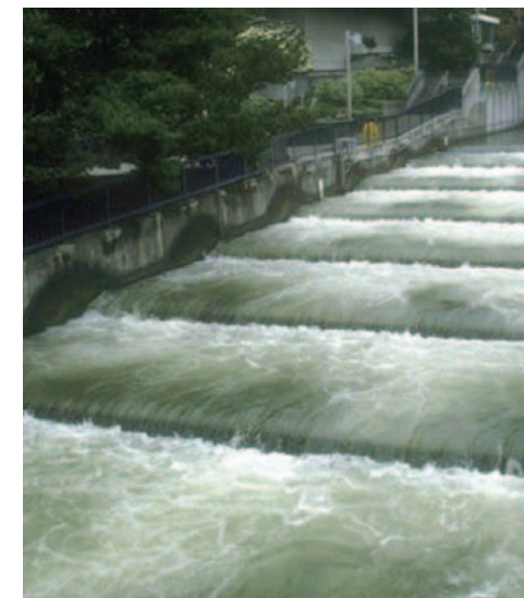
Das Prinzip der Geschwindigkeitsregelung: Es erfolgt ein mehrstufiger, kontrollierter Druckabfall, wodurch Probleme wie Kavitation, Erosion, Lärm und Vibration vermieden werden können.
